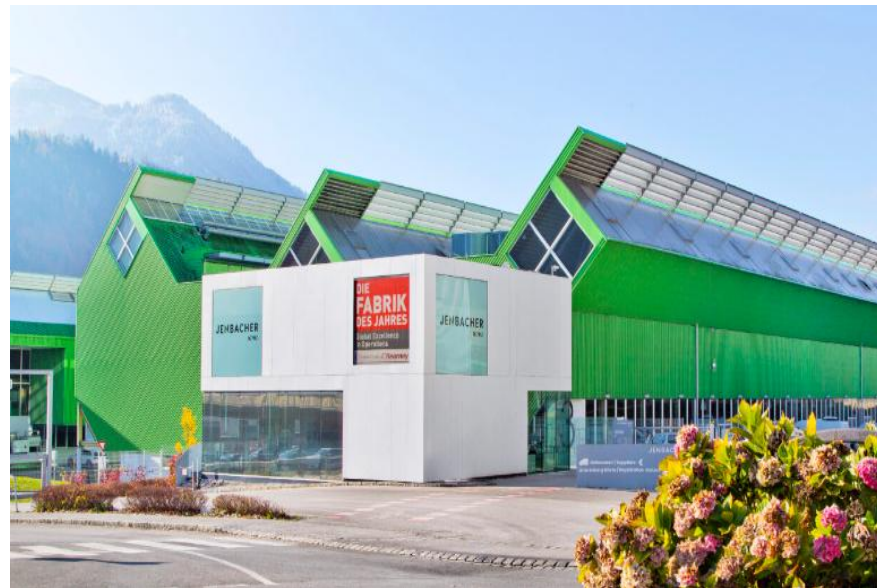
© INNIO Jenbacher GmbH & CO OG
